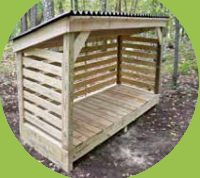
Začasno skladišče za drva
