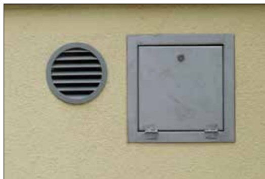
Odprtina na zunanji steni stavbe za dovajanje lesnih pelet v zalogovnik.
